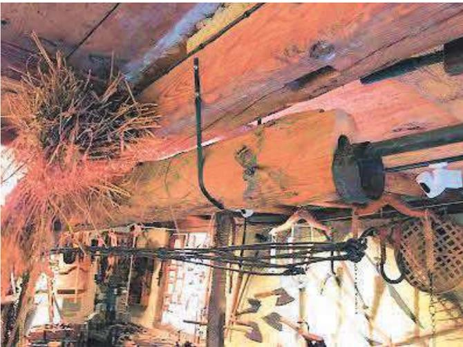
Zum Reinigen der Leitungen wurden Teuchelruten verwendet. Auf dem Bild links hängt dieses Gerät unter dem Teuchel. Die Rute ist an den Gelenken zusammengeschnitten. Auseinandergefaltet ist die Rute ca. 20 Meter lang.
