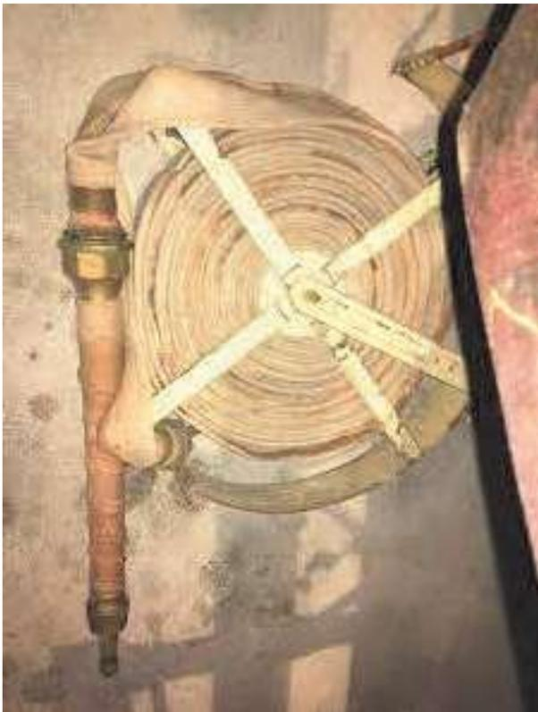
Im 19. Jahrhundert wurde in vielen Städten mit der Wasserversorgung auch die Feuerwehr ausgebaut, so dass in jedem Stockwerk eine Schlauchhaspel zur Brandbekämpfung installiert werden musste. Beim Abbruch der Druckerei Eidenbenz an der Davidstrasse in St. Gallen konnte ein Stück Geschichte durch Bruder Paul gerettet werden.
