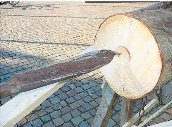
Nachdem alle Vorarbeiten erledigt waren, konnte mit dem Bohren begonnen werden. Zwei Mann drehten am Quergriff des Teuchelbohrers. Dabei musste sehr genau darauf geachtet werden, dass der Bohrer nicht verlief und seitlich aus dem Stamm austrat.
