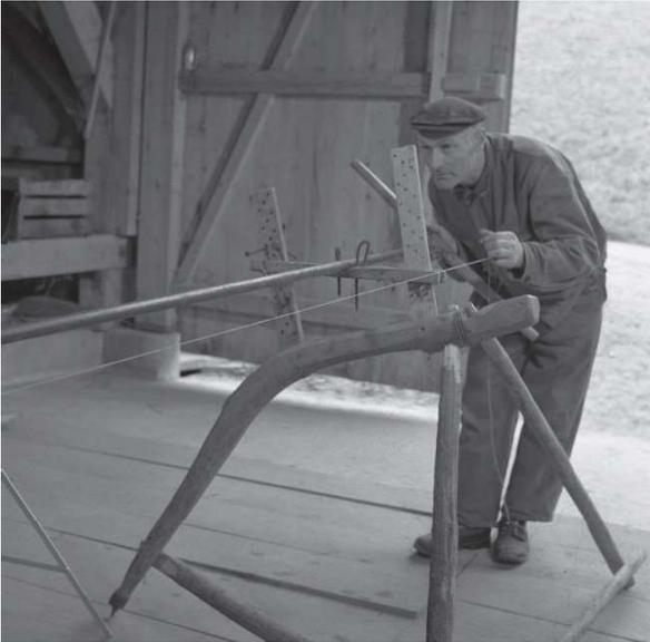
Die Stämme mussten gerade gewachsen sein. Dann wurden sie auf zwei Böcke gespannt und verkeilt. Dann musste der Auflagebock für den Bohrer sowohl in der Breite als auch in der Höhe positioniert werden. Je genauer diese Positionierung
